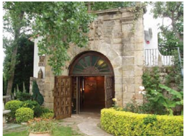
Foto de la entrada de la galería
